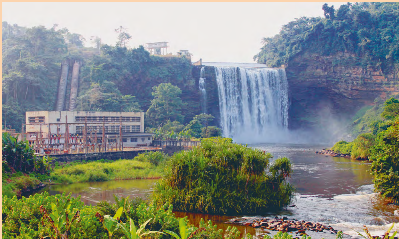
MOUKOUKOULOU Le barrage hydroélectrique
