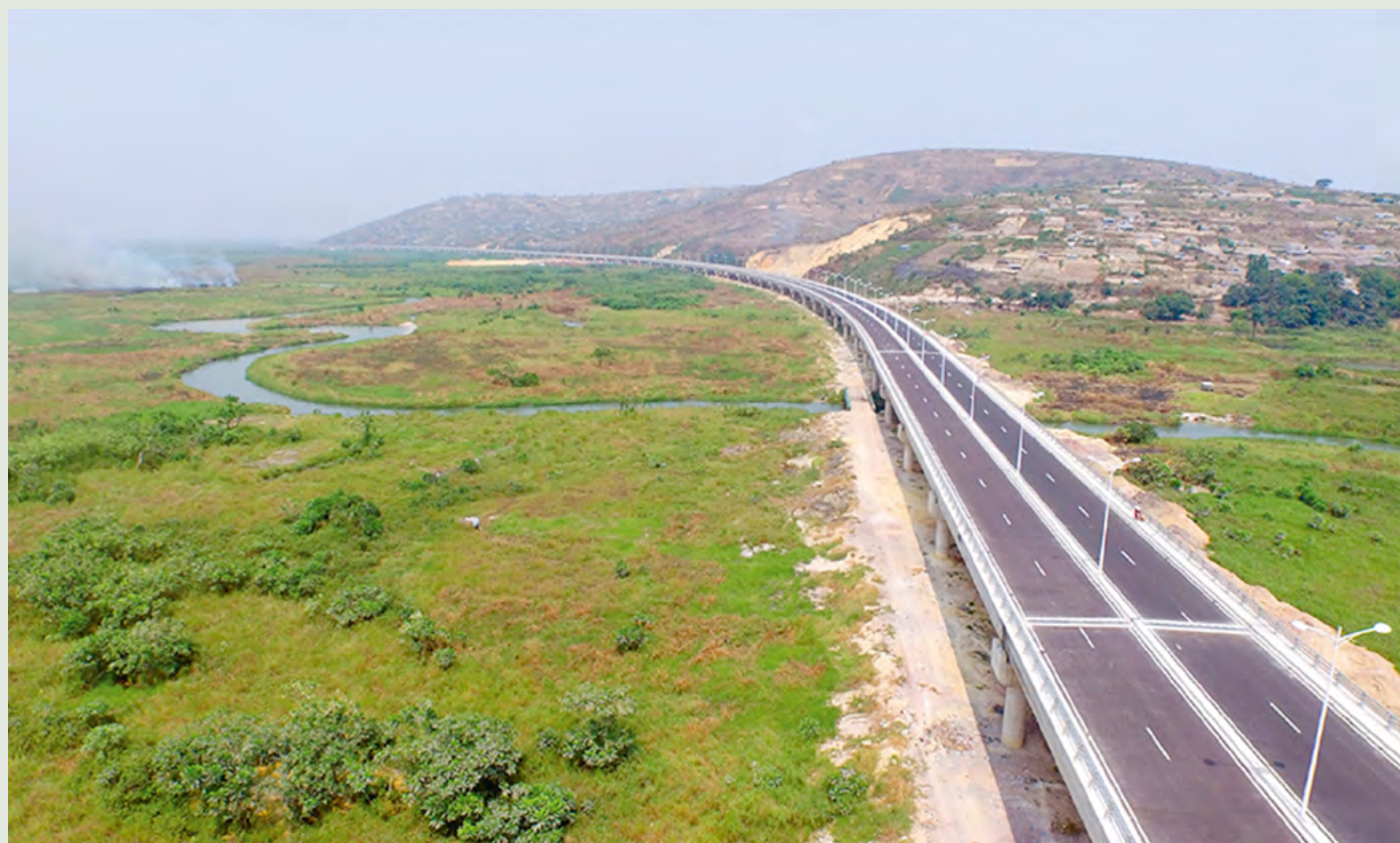
Le viaduc Talangaï-Kintélé
