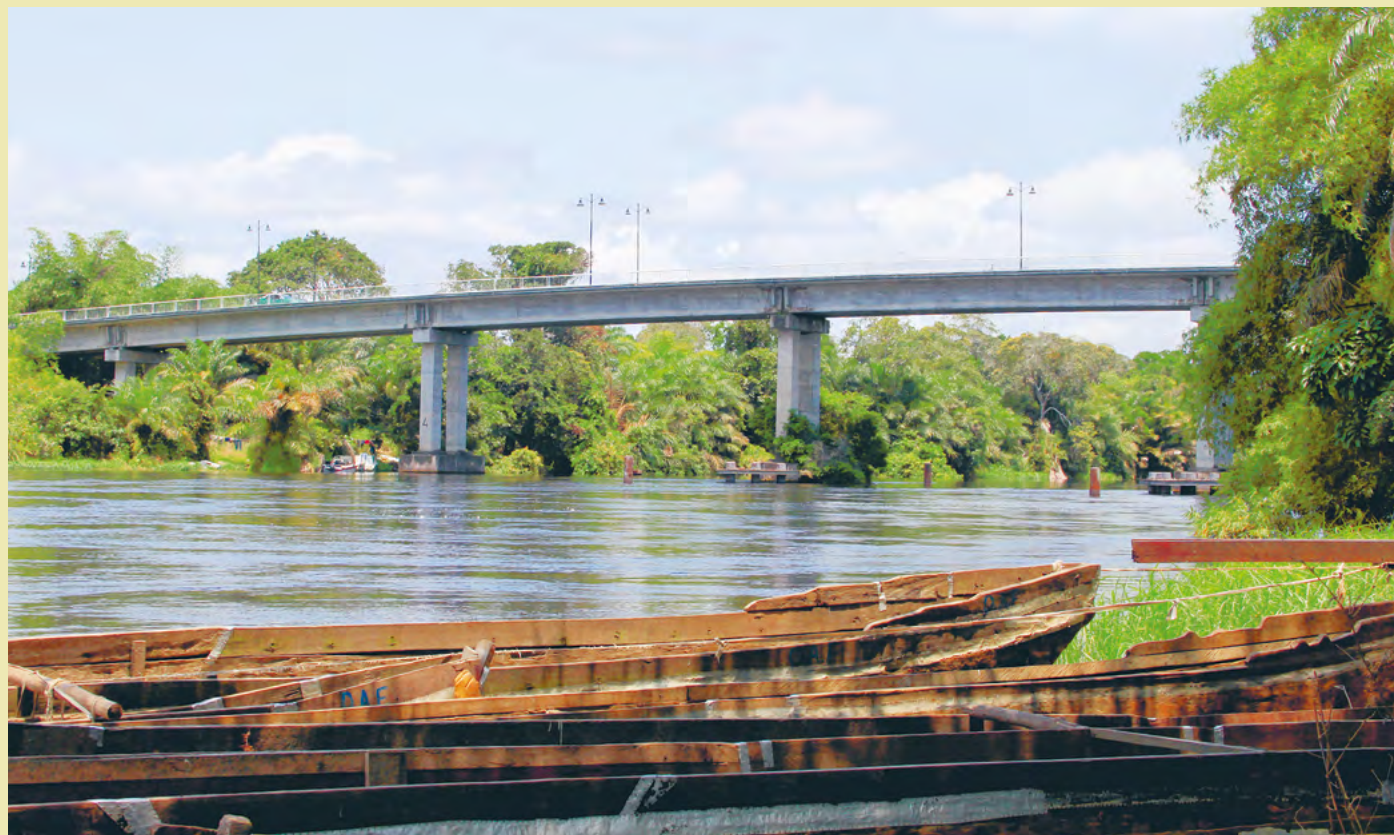
OYO Pont sur l'Alima
